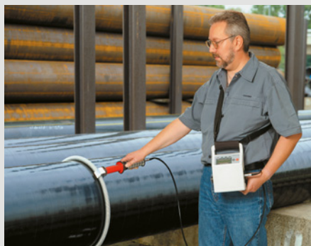
Porenprüfung an Pipelines
